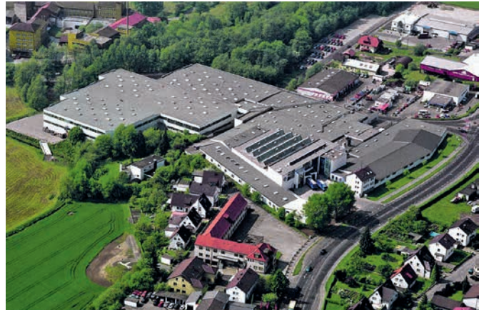
Luftbildaufnahme COKA (ohne Neubau)
